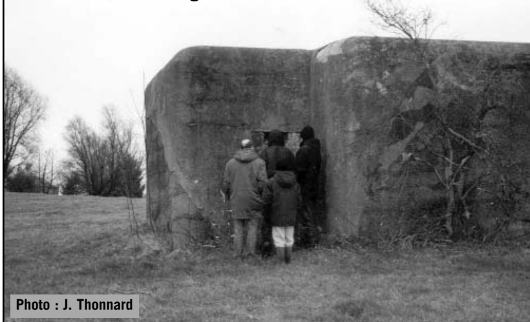
Un des bunkers aménagés à Petit-Rechain
