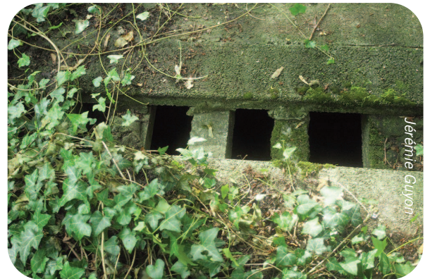
Biez 2 : entrée "Degeneffe" où l'on va disquer les hourdis
