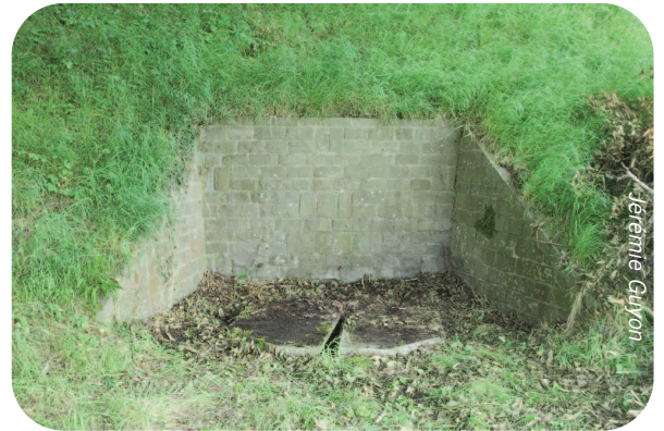
Biez 1 : entrée "SWDE" où l'on va installer un dispositif permettant un meilleur accès pour les chauves-souris
