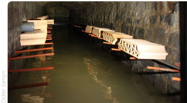
Briques plâtrières posées sur des tiges en métal
