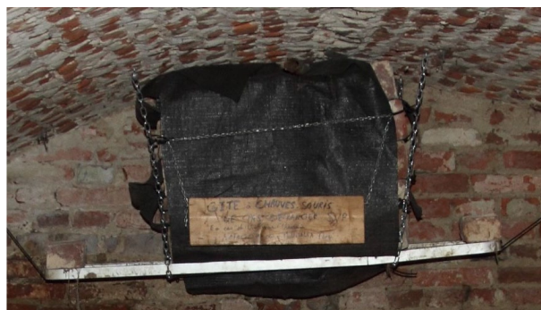
Structure suspendue entourée de toile vinyle
