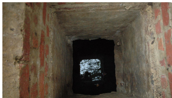
Accès à la galerie drainante de Gaillemarde
