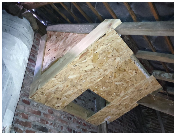
Hot-box isolée sous la toiture en ardoise
